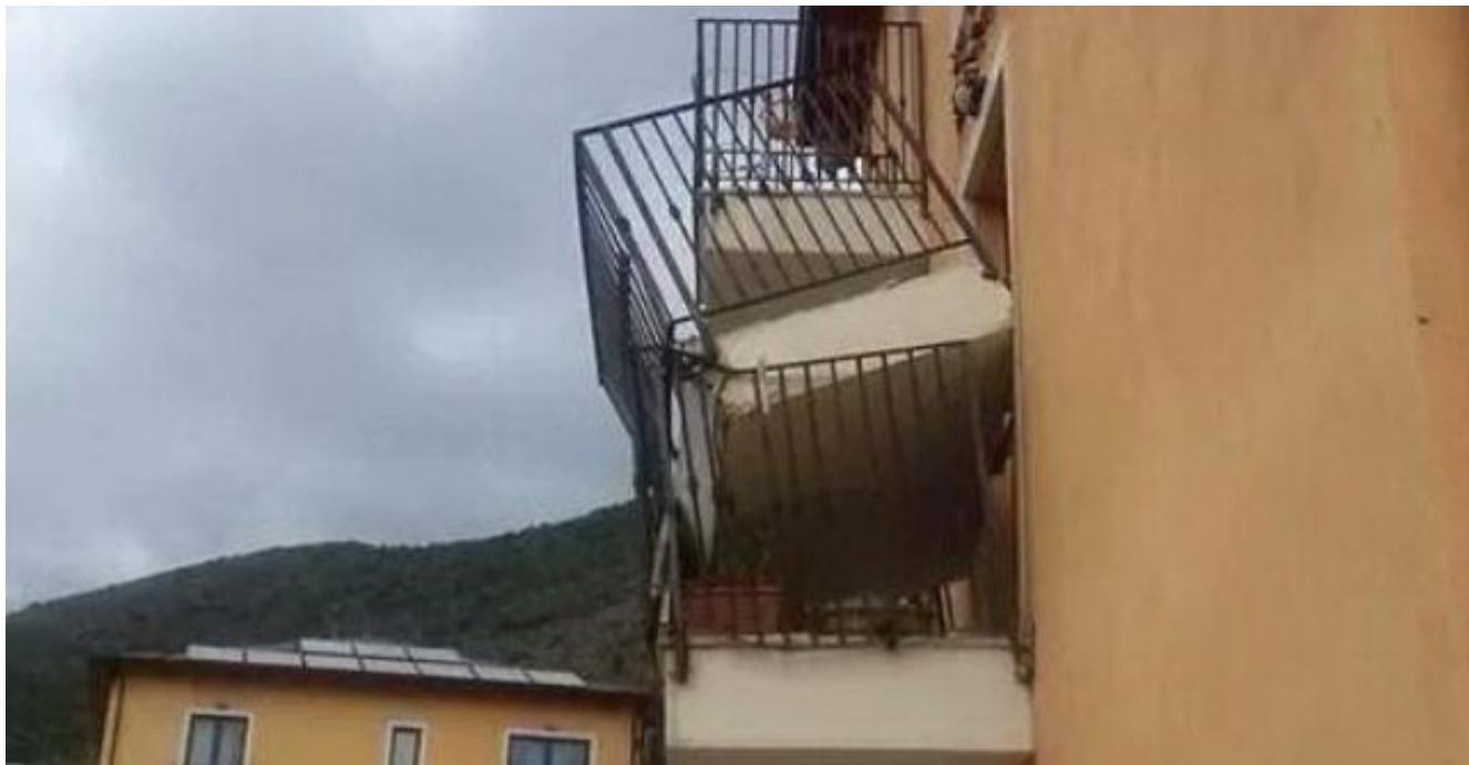
L'AQUILA, 4 SETTEMBRE 2014 – Panico e terrore ieri a Cese Preturo: un balcone, di una palazzina antisismica costruita con il Progetto C.A.S.E., è letteralmente precipitato sul balcone sottostante, staccandosi dal sostegno al muro. Il palazzo e quello limitrofe è stato dichiarato inagibile e la famiglia è stata sgomberata.
