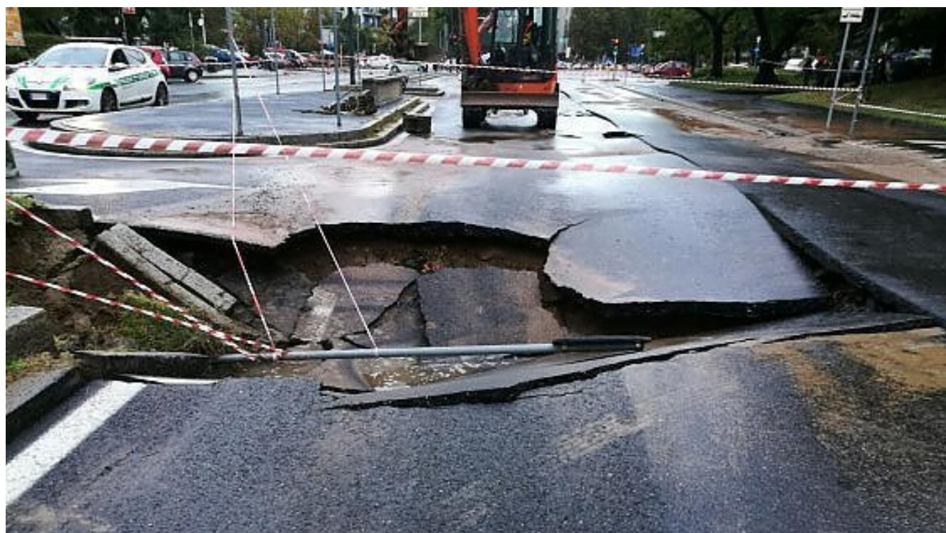
MILANO, 10 OTTOBRE - Un allagamento "con ampio cedimento della carreggiata stradale" ha interessato zona Bande Nere a Milano nella notte tra domenica e lunedì. A quanto pare il danno maggiore sarebbe stato causato dalla rottura di un tubo, con cedimento dell'asfalto e chiusura di via Bartolomeo d'Alviano.[MORE]
